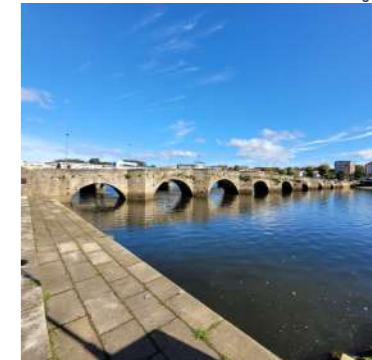
Ponte do Burgo
