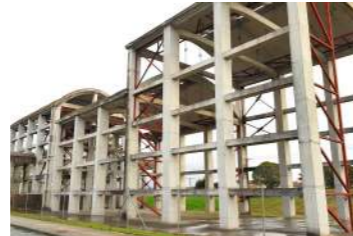
Estructuras da fábrica de Cros
